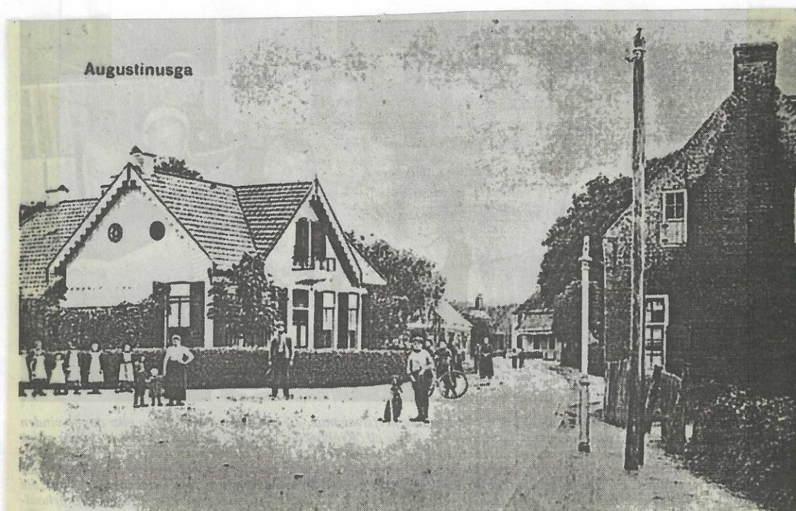
De hoek Skoalikkers/Geawei in 1901. Links de woning van notaris Landmeter, de eerste voorzitter van Dorpsbelang. Rechts de z.g. Armenkamer, "Steilenburg" bewoond door drie gezinnen. Dit pand werd door de notaris in 1907 aangekocht en is later afgebroken.
